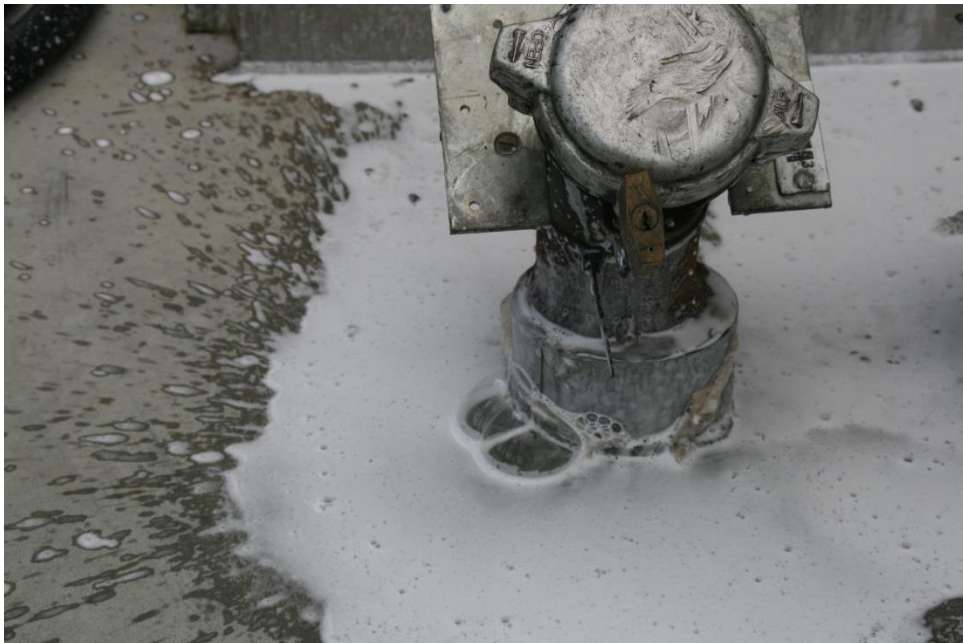
Foto: luchtlekkage Luchtlekkage bij doorvoer.
