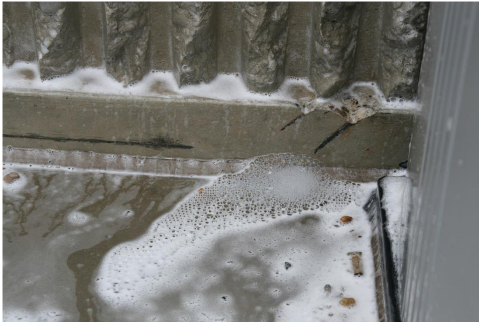
Foto: luchtlekkage Luchtlekkage bij aansluiting.
